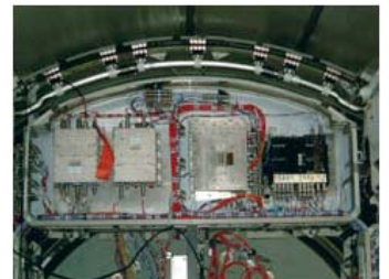
ProCurve Switch 2524 被安装到哥伦布实验舱模块上
