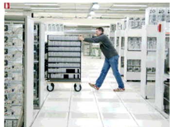
CERN 数据中心
